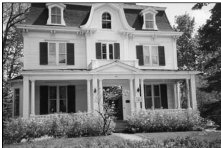
Fig. 5. Maison Morey, rue Dufferin, 1998 Construite v. 1875 (photo de l'auteure)
