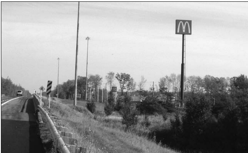
Autoroute 40 à Donnacona (photo : ministère des Transports)
