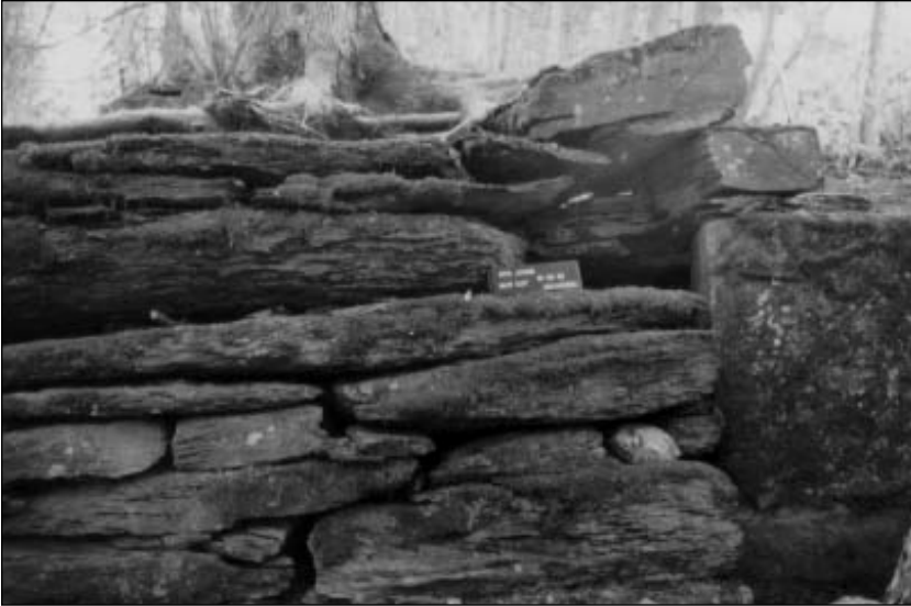
Figure 6: Détail du parement du mur est du moulin hydraulique du site Jones (BgFb-6) à Vale Perkins; l'échelle mesure un mètre.
